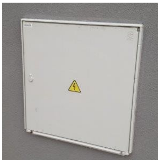
obr. /36/ Elektroinstalační skříň ve výklenku fasády objektu
