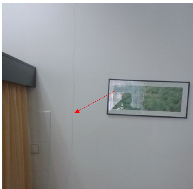
obr. /7/ Trhlina v předsíni (kuchyňce)
