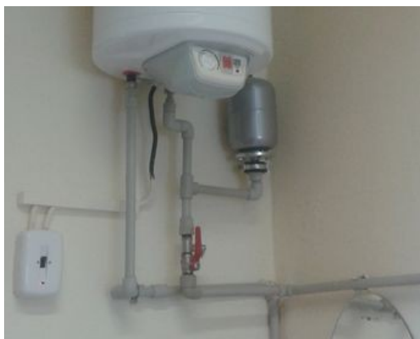
obr. /28/ Rozvody pitné vody vedeny v polypropylenových trubkách
