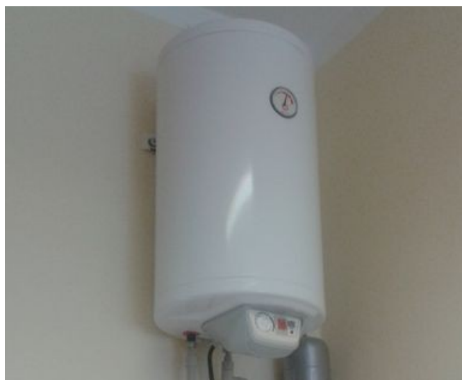
obr. /35/ Pohled na zásobníkový ohřivač teplé vody
