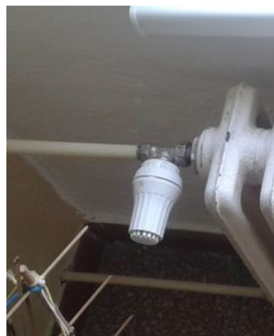
obr. /33/ Zábovní termostatická hlavice
