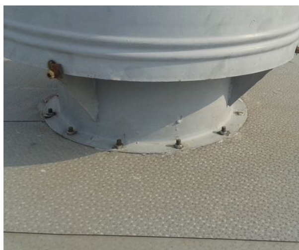
obr. /21/ Nedostatečné vytažení hydroizolační fólie na výduch VZT hlavice
