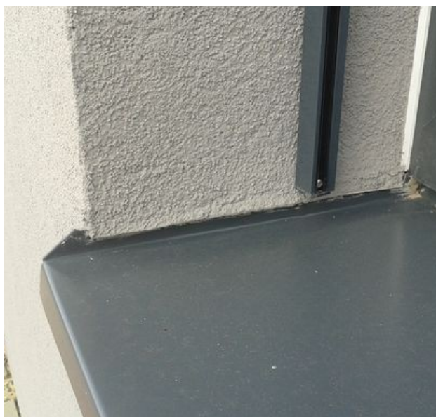
obr. /24/ Boky oplechování parapetů jsou zapuštěny do fasády
