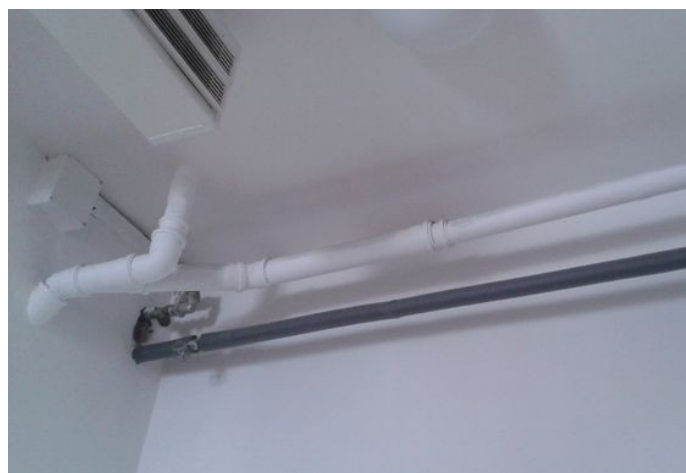
obr. /27/ Na ležatém odpadním potrubí se nenachází dostatečný počet kotevních prvků
