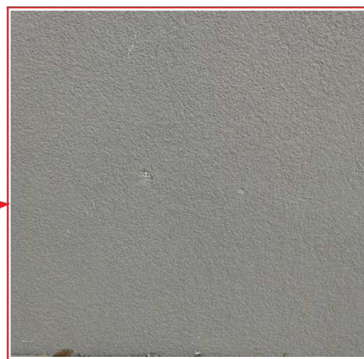
obr. /5/ Mechanické poškození vnější omítky na severozápadní straně fasády
