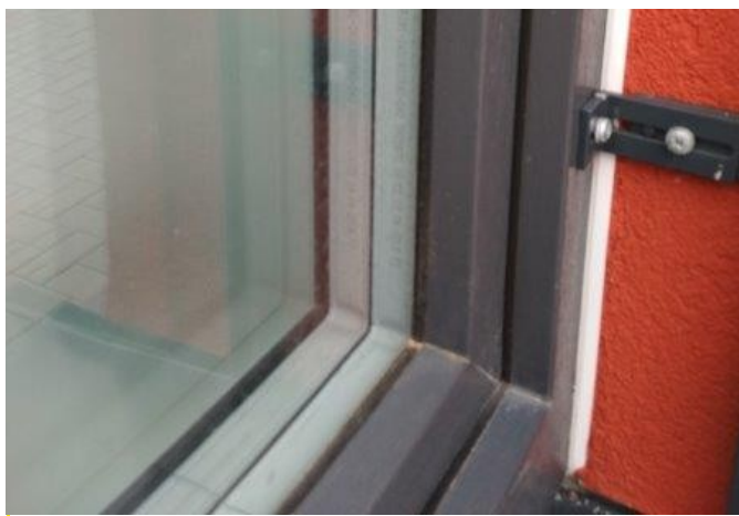
obr. /13/ Okenní křídla jsou zasklena izolačními trojskly
