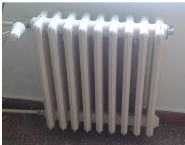
obr. /32/ Původní litinový článkový radiátor
