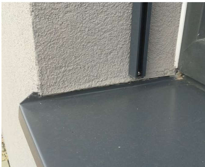
obr. /14/ Oplechování parapetu opatřeného šedým lakem
