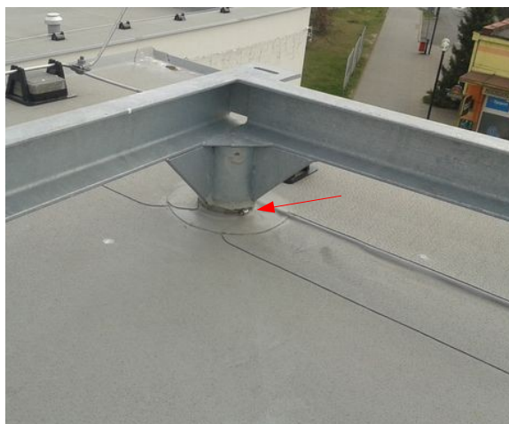
obr. /22/ Nedostatečné vytažení fólie v místě ukotvení kovové konstrukce
