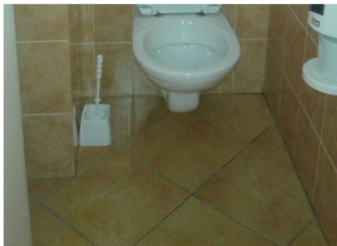
obr. /17/ Nášlapná vrstva WC je tvořena zánovní keramickou dlažbou
