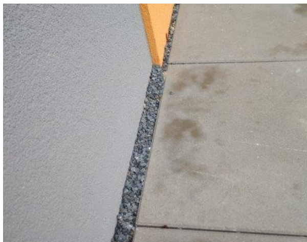
obr. /18/ Lokální netěsnosti okapového chodníčku jsou vyplněny štěrkem
