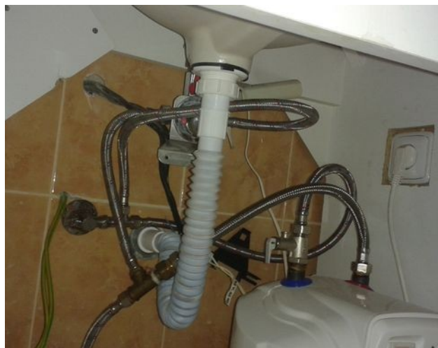
obr. /29/ Zápachová uzavírka s flexibilní trubicí
