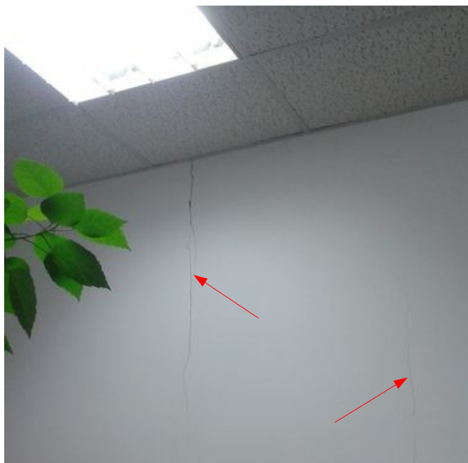
obr. /8/ Trhliny v předsíni (kuchyňce)
